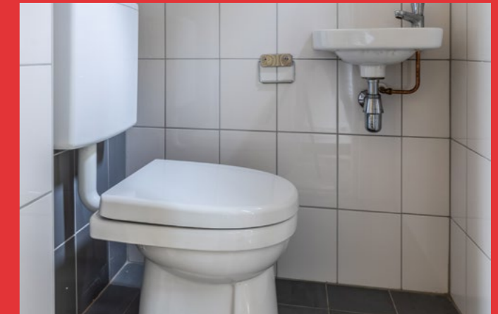
In dit gerenoveerde toilet kregen toiletput, fonteintje en spoelreservoir een tweede leven.
